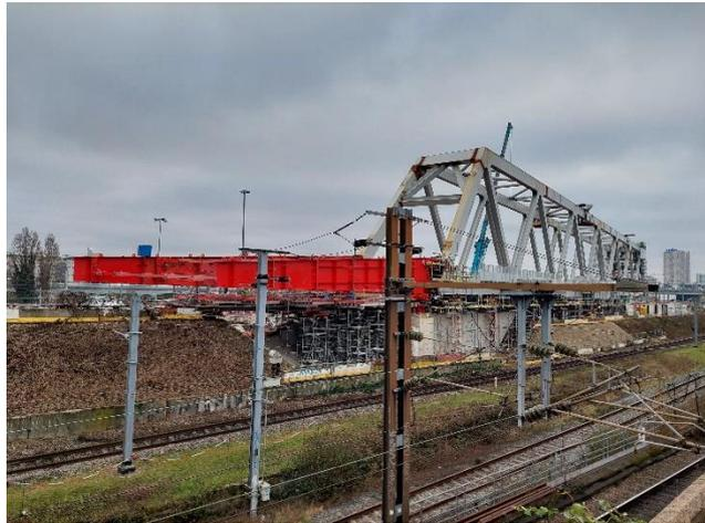
L'ouvrage avancera de quelques mètres par heure. A l'issue de l'opération, il sera positionné à l'aplomb de sa position définitive. La descente du tablier sur ses appuis définitifs sera effectuée à partir du 17 février. Une fois l'ouvrage en place, la dalle du tablier sera bétonnée.
